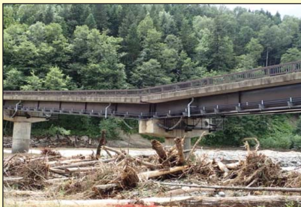
〔高原大橋(国道273号)〕
