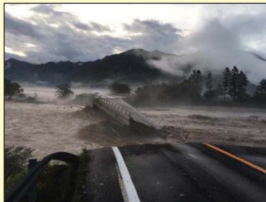
〔千呂露橋(国道274号)〕
