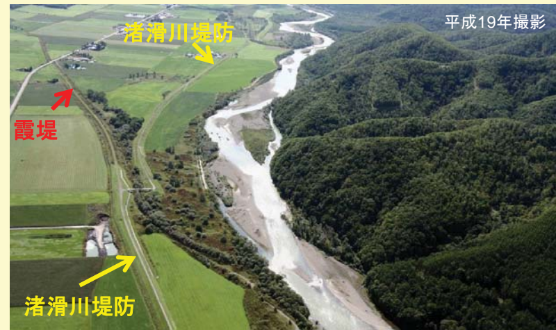
霞堤施工事例(渚滑川)
