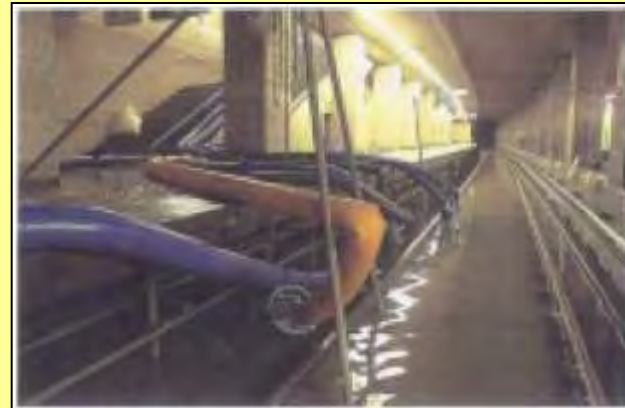
地下鉄駅での線路の冠水 〔平成11年福岡豪雨〕
