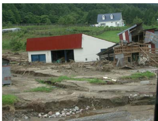
〔土砂堆積により被災した家屋〕
