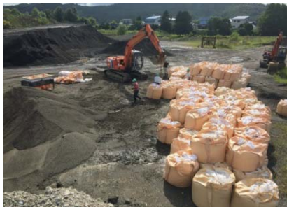
仮締切り用大型土のう製作状況
