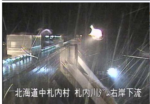
8月30日21:20 札内川ダム右岸下流 札内川ダムからの越流状況
