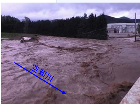
8月31日4:40 空知川上流 幾寅地区 堤防決壊状況
