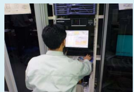
洪水予測システム操作状況
