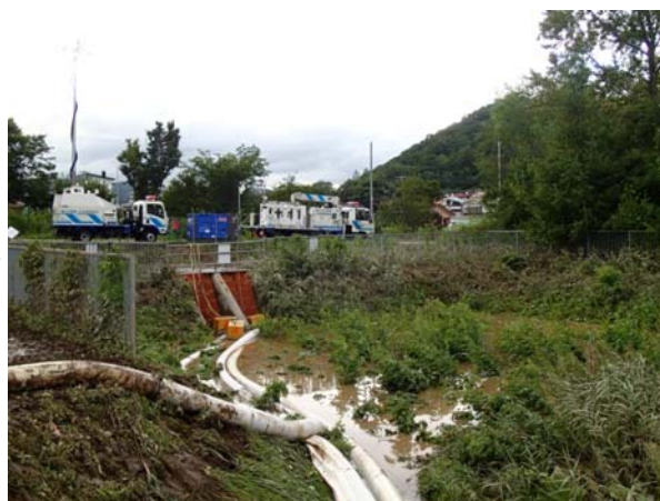
排水ポンプ車による排水作業状況
