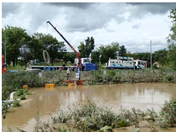
排水ポンプ車による排水作業状況
