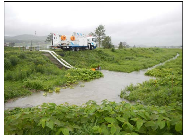
石狩川水系オサラッペ川 鷹栖町北斗地区
