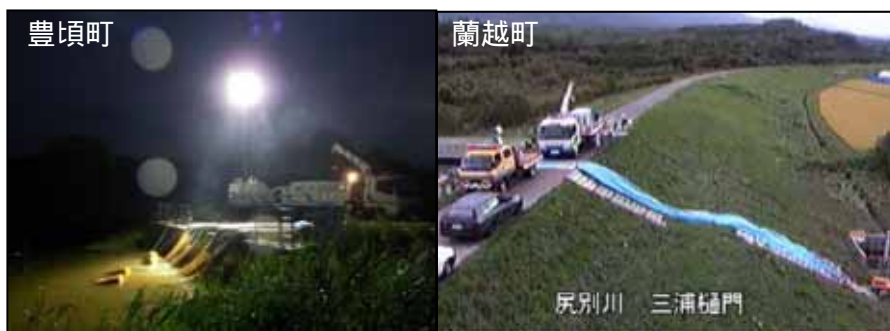
排水ポンプ車による内水排除状況(豊頃町、蘭越町)
