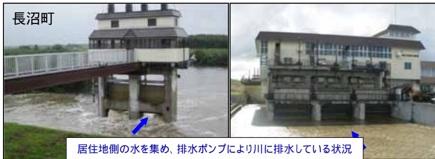
南6号排水機場による内水排除(長沼町)
