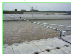
水位を計測する装置 (電波式水位計)
