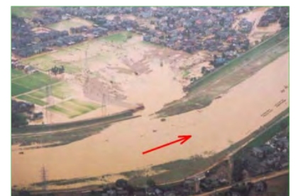
信濃川水系五十嵐川諏訪地区の破堤氾濫状況 (2004.7.13 新潟豪雨洪水災害調査委員会報告書より)
