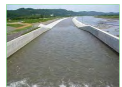
実験水路全体 (低水路幅: 30 m)
