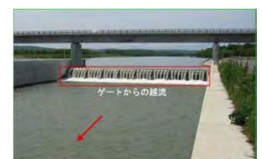
流量調節施設 (起伏式ゲート:幅43m)
