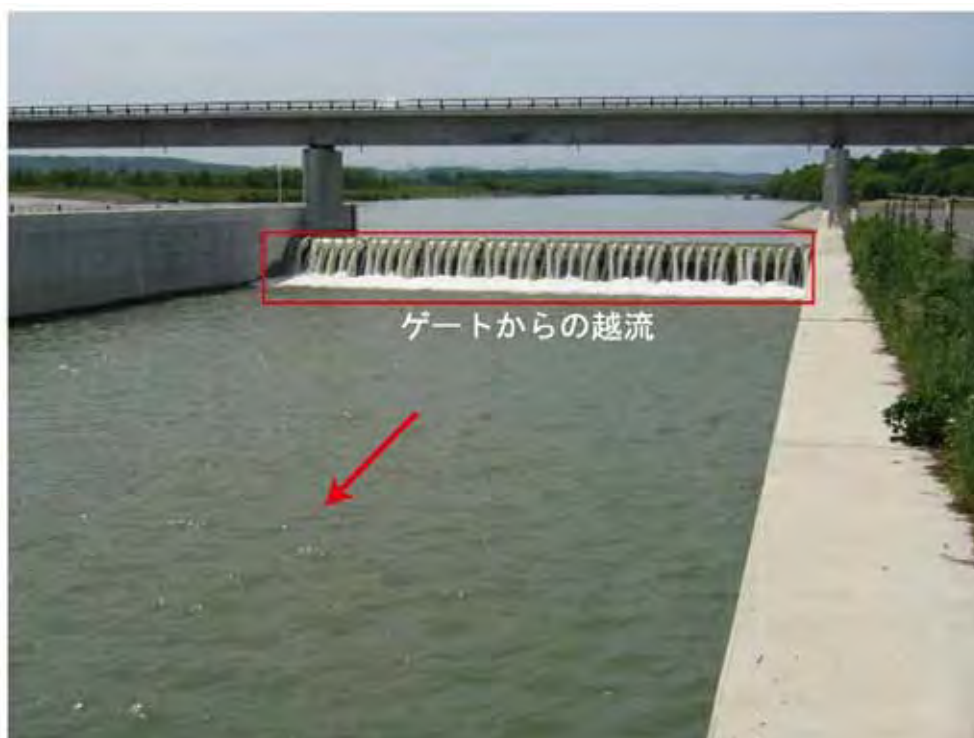
写真- 15 ゲートからの通水状況
