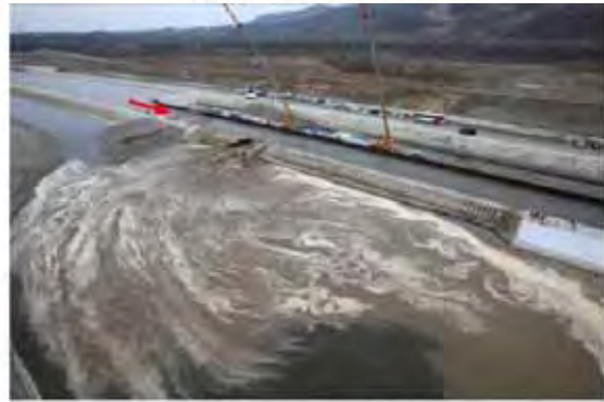
破堤進行過程 (t=60min)
