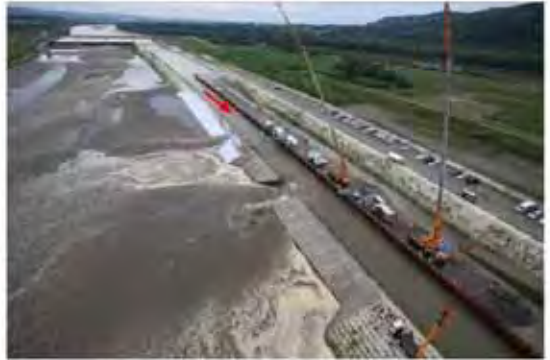
破堤進行過程 (t=34min)
