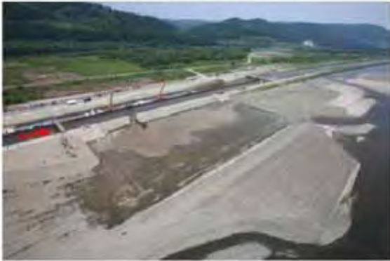
破堤進行過程 (t=48min)
