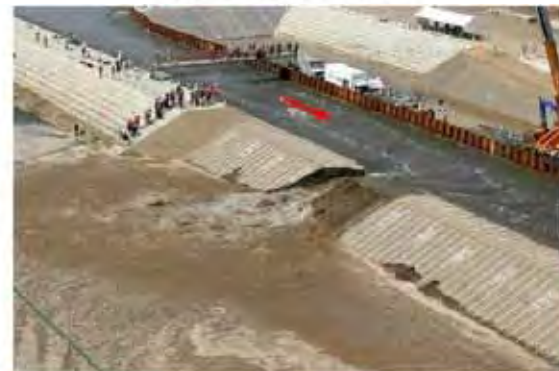
破堤進行過程 (t=16min)
