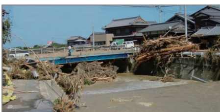
橋脚への流木閉塞被害例 (平成16年 水害レポート2004河川局HPより)
