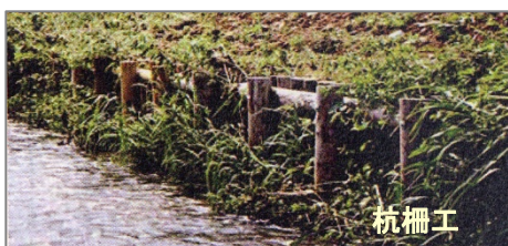
耐流速試験を実施した多自然工法の例
