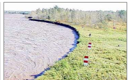
高水敷侵食の様子、札内川 (H14十勝川水系河相変化調査業務より)
