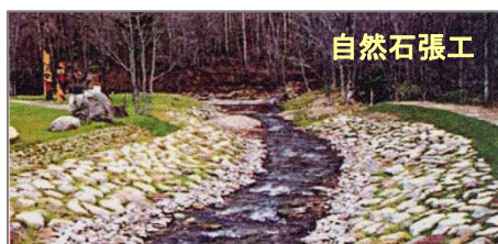
耐流速試験を実施した多自然工法の例
