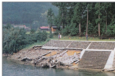
保護工の被害事例 (美しい山河を守る災害復旧基本方針より)
