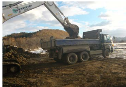
ダンプトラックへ積み込み、
