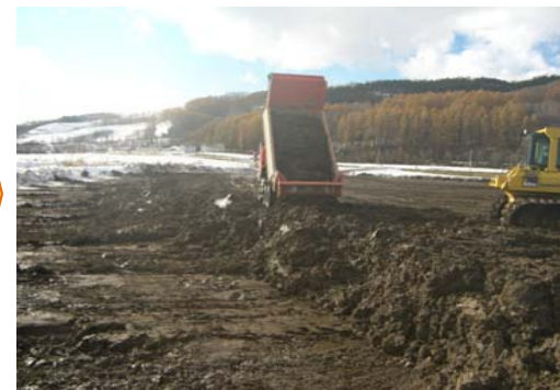
土砂が流出した農地へ運搬し、
