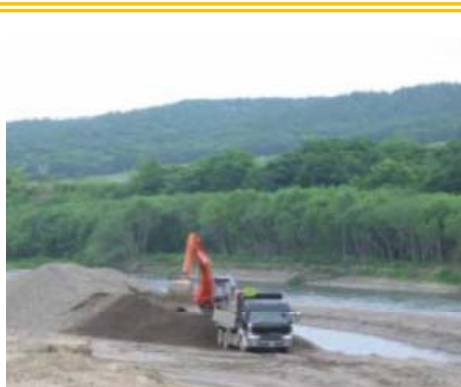
河道掘削した土砂を、
