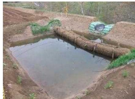
写真：実施中に設置した沈砂池
