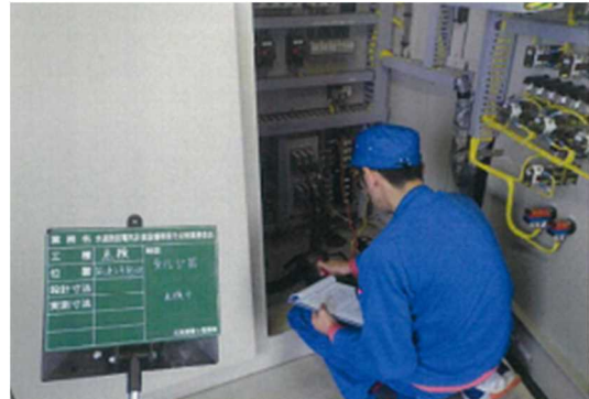
風蓮2号ファームポンド（保守点検） （別海町からの提供）
