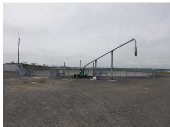
写真：配水調整池 （令和３年６月撮影）
