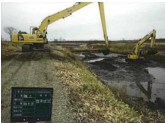
第三西別川排水路 （土砂除去作業）（別海町からの提供）
