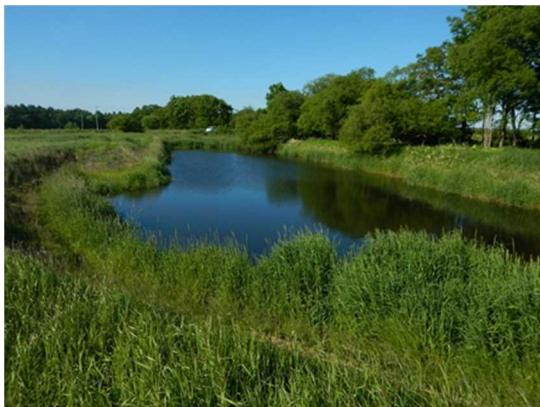
写真：遊水池（然内川排水路） （令和３年６月撮影）
