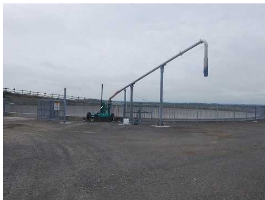
写真：配水調整槽 (令和3年6月撮影)
