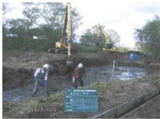
第七川排水路1号排水路 （土砂除去作業）（別海町からの提供）
