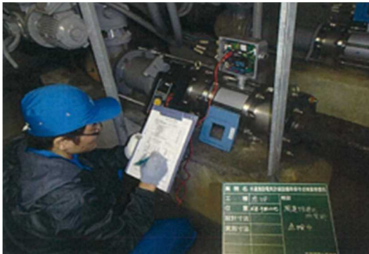
風蓮1号ファームポンド（保守点検） （別海町からの提供）
