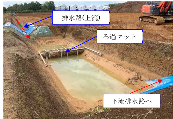
濁水処理施設の設置状況 (令和5年7月撮影)
