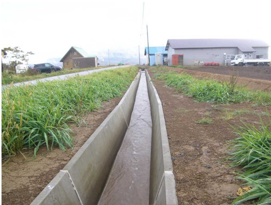
既設トラフ再利用設置状況 (令和3年10月撮影)
