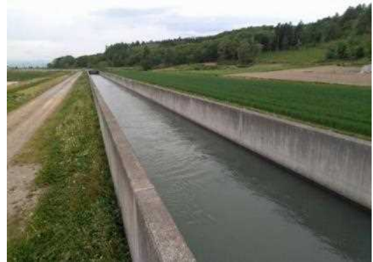
当別幹線用水路（改修後） （令和5年5月撮影）
