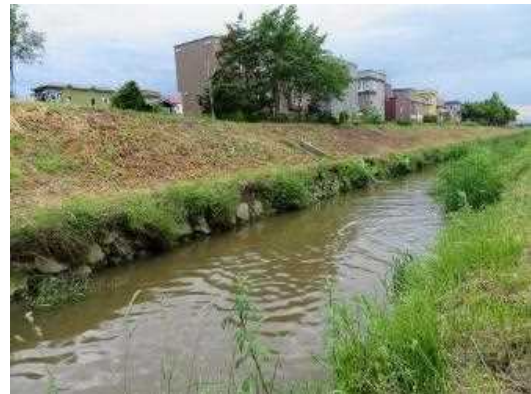
写真：基線排水路の自然石護岸 (令和5年6月撮影)
