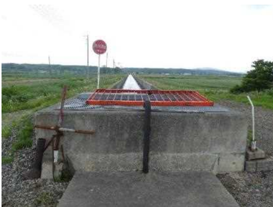
写真：用水路に整備された防火用水施設 (令和5年6月撮影)
