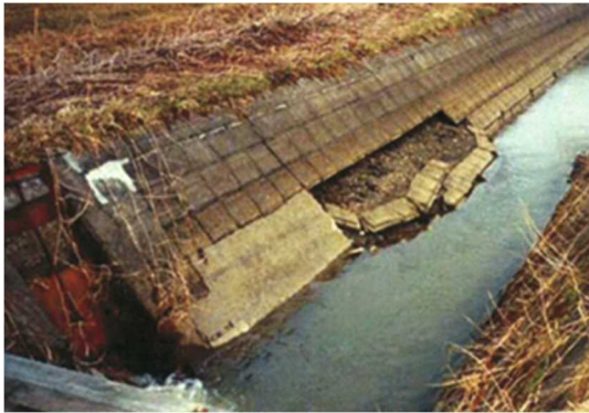
当別幹線用水路（改修前） （札幌開発建設部）
