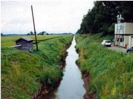
写真：整備前の基線排水路 （札幌開発建設部）
