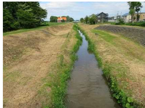
写真：基線排水路の親水広場 (令和5年7月撮影)
