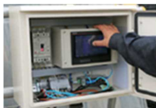
写真：かん水時間や土壌水分量の操作盤、及びかん水管
