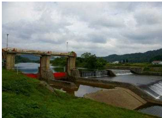
当別頭首工 (札幌開発建設部)
