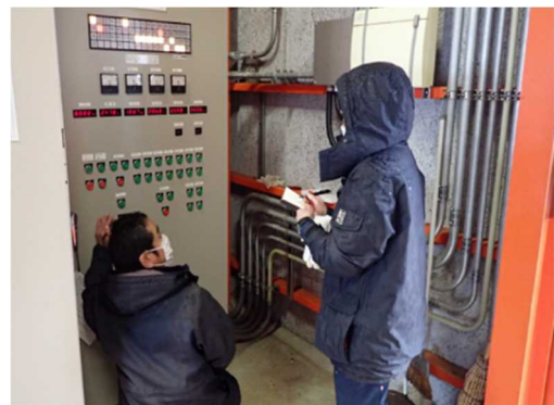
写真：青山ダム取水操作設備点検 (当別土地改良区からの提供)
