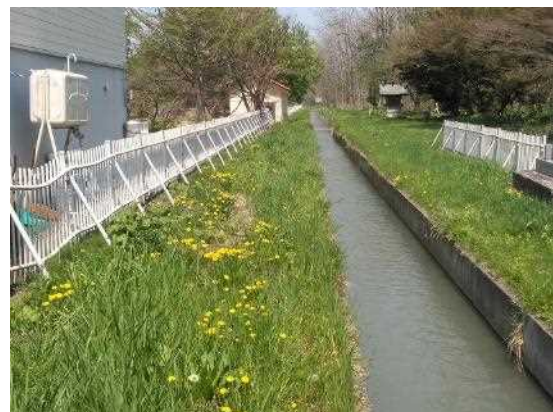
写真：西太美用水路に設置されたフェンス (令和5年5月撮影)
