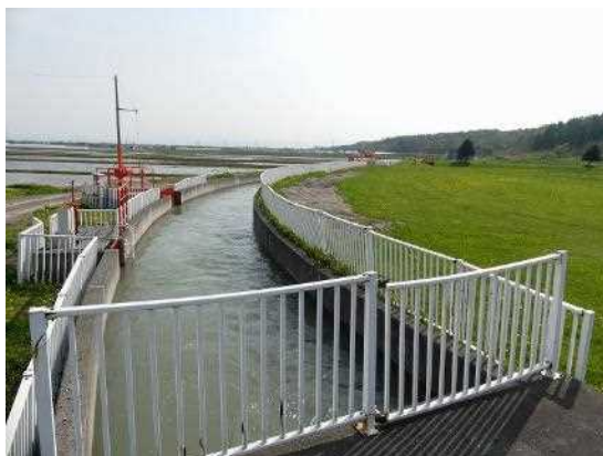
写真：当別幹線用水路に設置されたフェンス (令和5年5月撮影)
