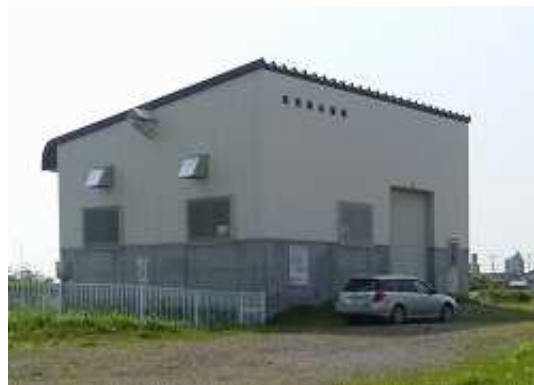
東裏揚水機（改修後） (令和5年5月撮影)
