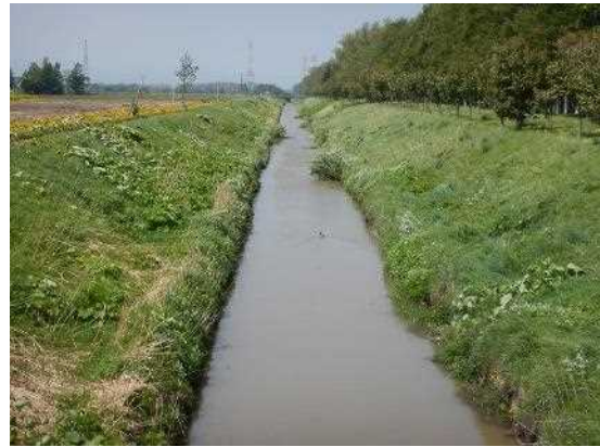
写真：整備後の基線排水路 （令和5年5月撮影）
