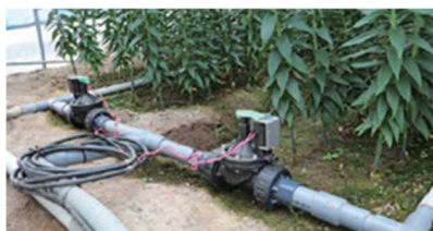
写真：かん水時間や土壌水分量の操作盤、及びかん水管
