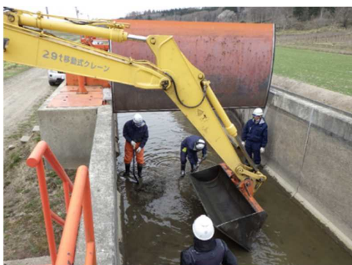
写真：当別幹線用水路土砂除去 (当別土地改良区からの提供)
