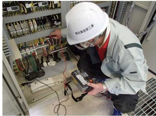
写真：緑ダム放流操作設備点検
