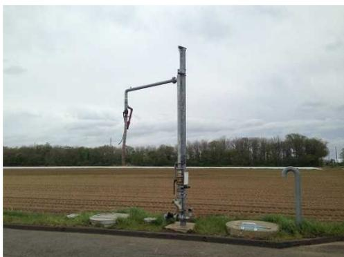
写真：多目的給水柱
