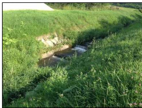
写真：ペケレイ川排水路（魚道つき落差工）
