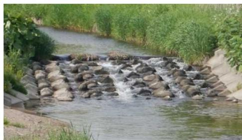
写真：緩傾斜型落差工（整備後）
