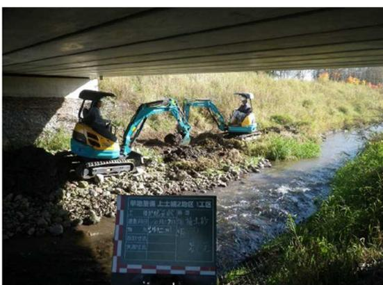
写真：堆積土砂の除去作業
