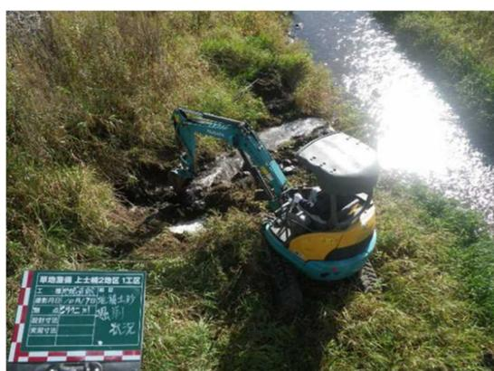
写真：堆積土砂の除去作業
