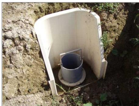
写真：水位調整型落口工
