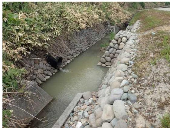
石積護岸工法により整備された排水路
