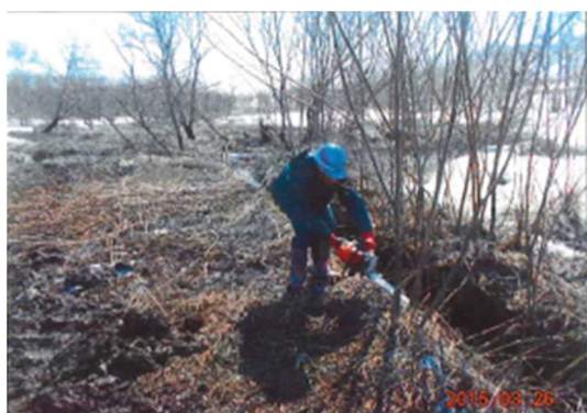
写真：右支姉別川遊水池周辺の伐採作業
