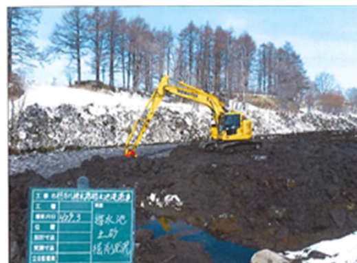
写真：熊牛川排水路遊水池浚渫作業
