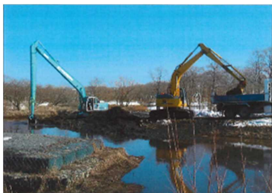
写真：右支姉別川遊水池浚渫作業
