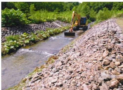
写真：取水施設の土砂上げ
