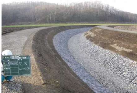
写真：排水路工事（フトン箆施工）
