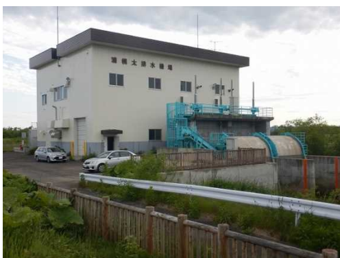
写真：浦幌太排水機場
