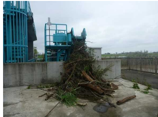
写真：排水機場（流木撤去）
