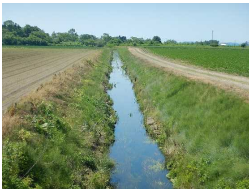
写真：浦幌3号排水路の状況
