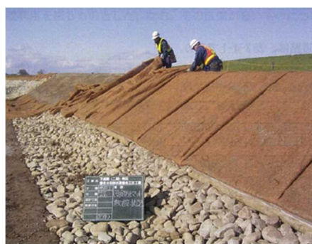
写真：排水路工事（木枠と植物繊維マット）
