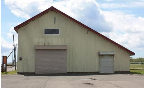
別海町に現存している「缶詰所」の建物の一部
