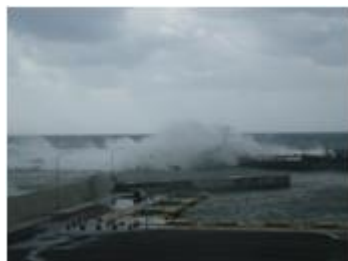
防波堤からの越波状況
