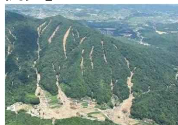
同時多発的な表層崩壊や土石流
