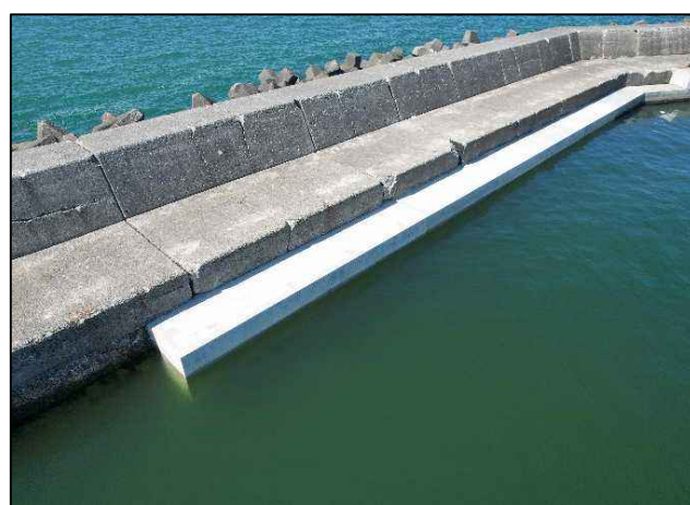
プレキャスト型枠を活用した長寿命化対策
