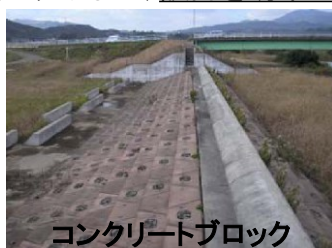
越流堤の構造の例
