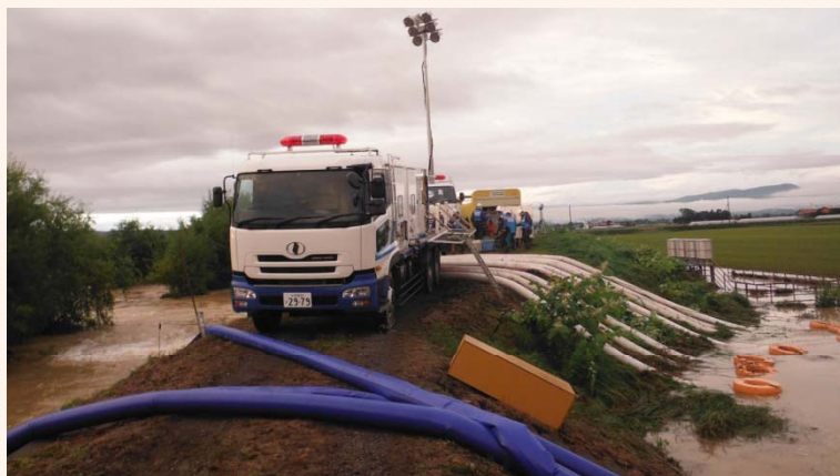
名寄市風連(タヨロマ川)で排水作業を行う排水ポンプ車(8/20)
