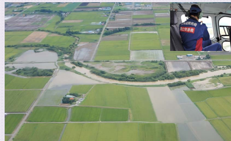
美唄幾春別川7号樋門周辺の浸水状況(8/21)
