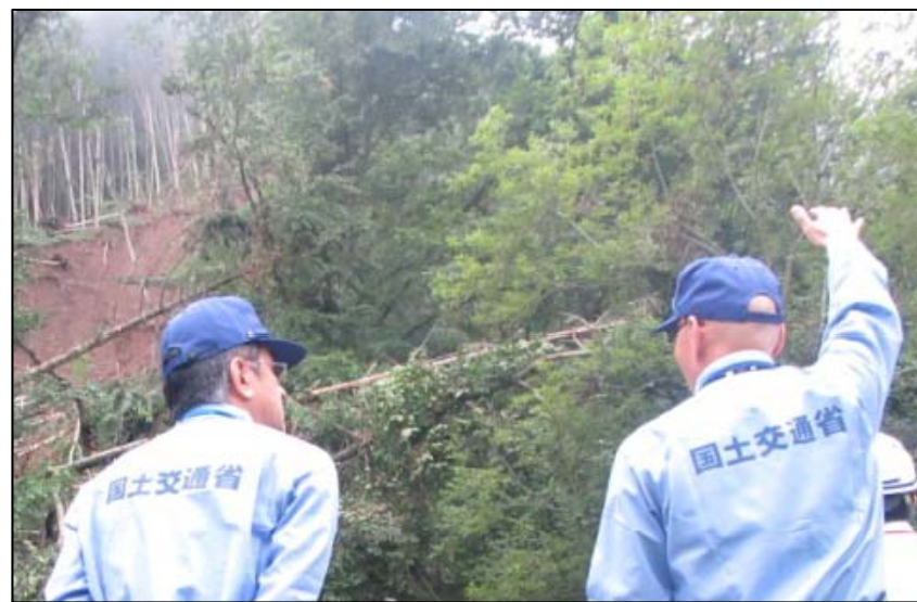
被災状況調査（8/25 白糠町 町道縫別川沿線）
