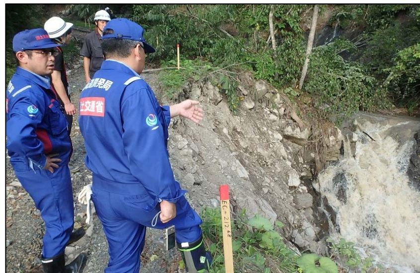
被災状況調査（8/25 愛別町 町道クルミ沢線）
