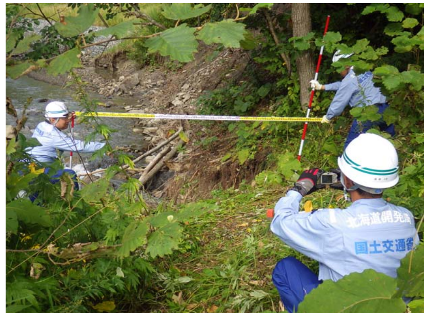
函館・小樽開建河川班 南富良野町金山ダム上流 町管理河川現地調査
