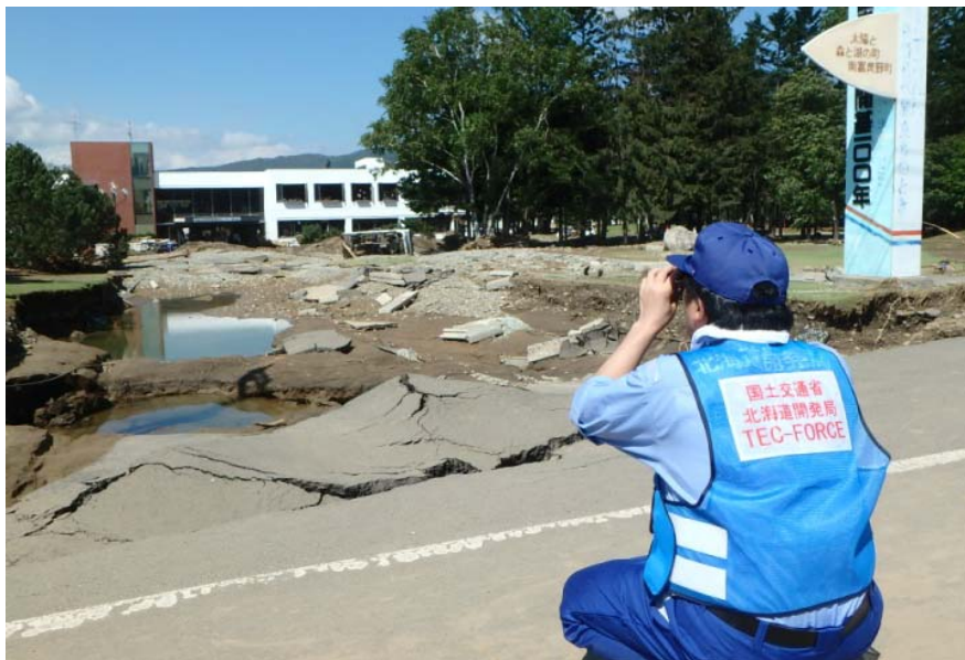
札幌開建道路班 南富良野町幾寅地区 被災箇所調査(9/2)
