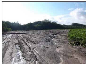
氾濫により土壌流出した農地(清水町)
