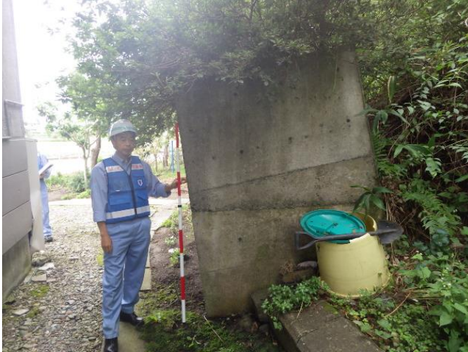
現地状況調査
