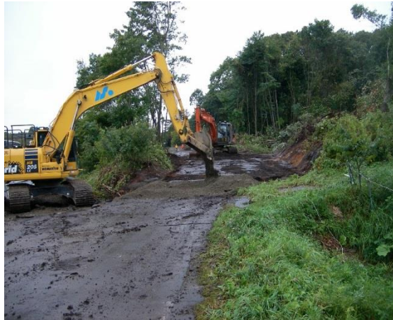
幌里地区（町道幌里本線） 啓開作業状況
