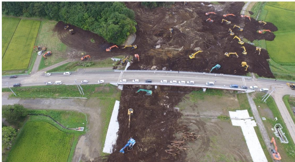
厚真川河道掘削作業状況
