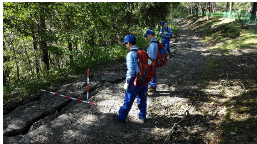
現地調査（北進浄水場裏山）
