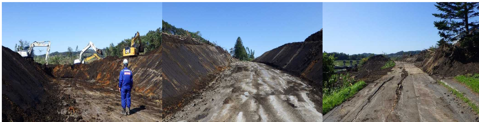
富里地区（道道上幌内早来停車場線）啓開完了
