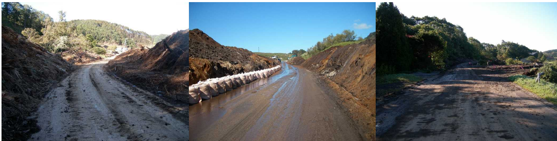
幌里地区（町道幌里本線）啓開完了
