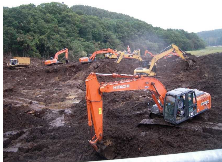
幌内橋河道掘削作業状況
