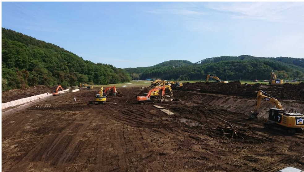
幌内橋河道崩積土撤去作業 (厚真川) 上流側 (北海道開発局)
