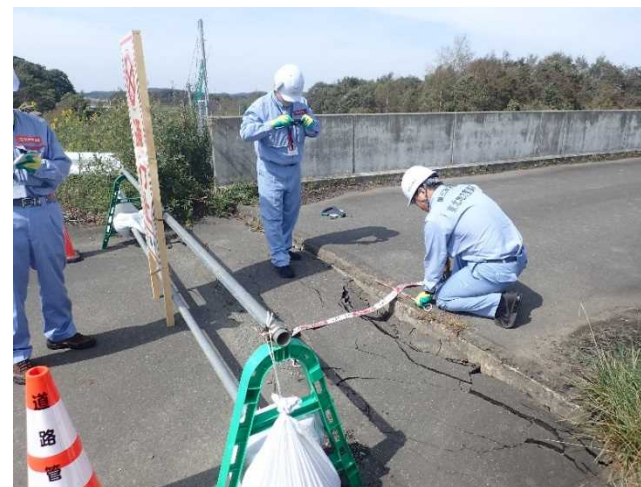
橋梁点検実施状況(青葉橋)
