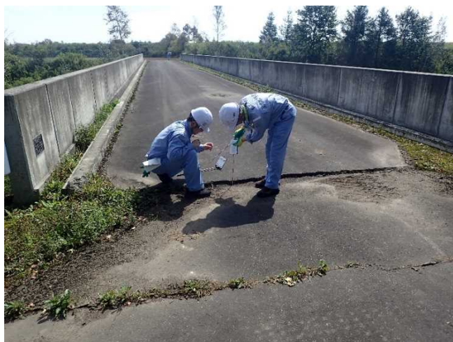
橋梁点検実施状況(御園第2橋)
