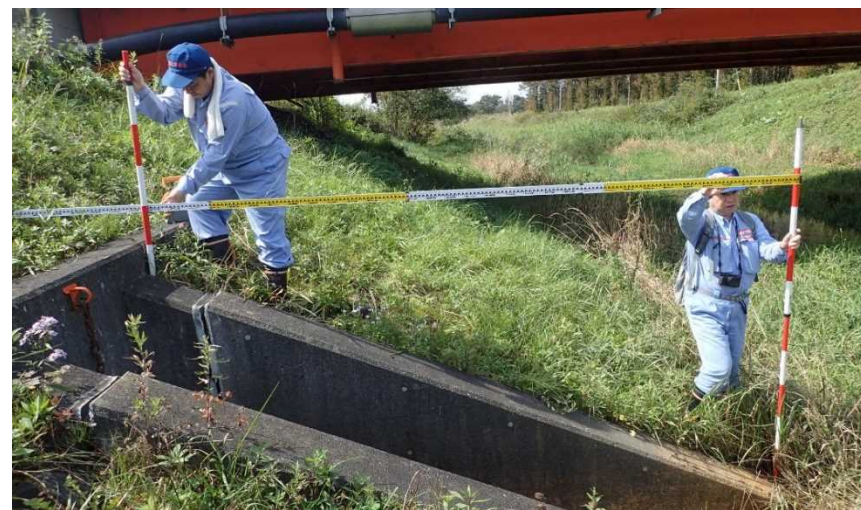
被害箇所計測状況
