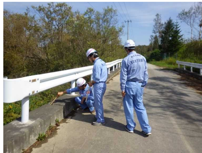
橋梁点検実施状況(美園橋)
