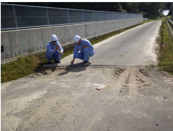
橋梁点検実施状況(美園第3号橋)
