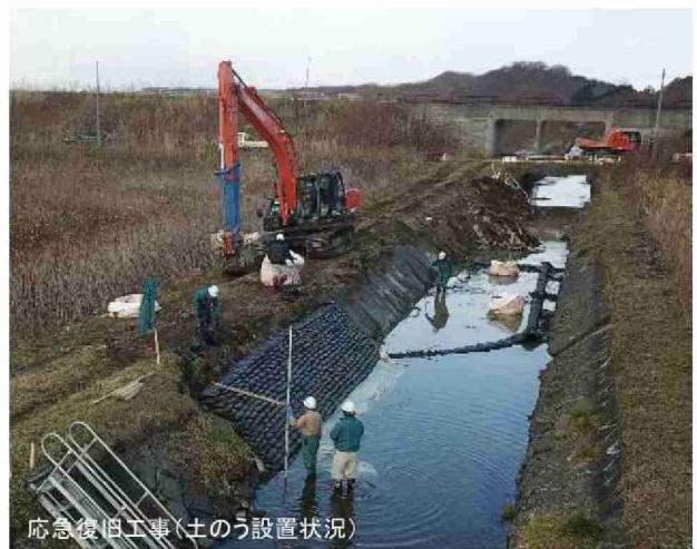
写真 6-6 被災した用水路の護岸の応急復旧
