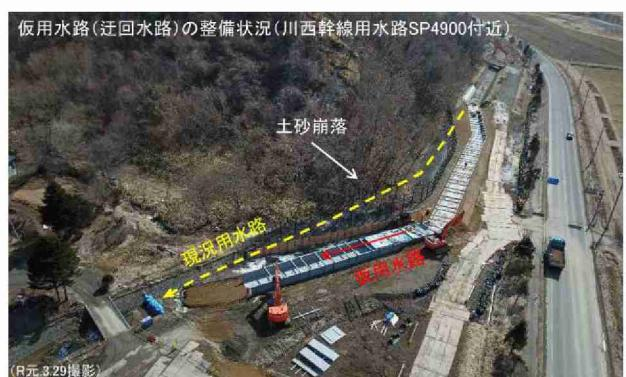
写真 6-5 河西幹線用水路の被災状況と仮用水路
