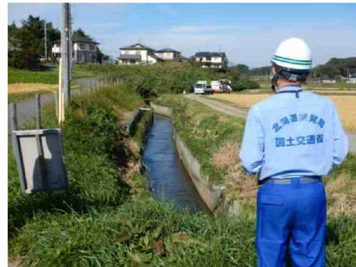
被災状況調査(河川被害箇所) (福島県須賀川市・長池川)
