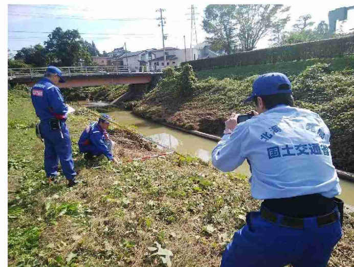
被災状況調査(河川被災箇所) (福島県本宮市・瀬戸川)
