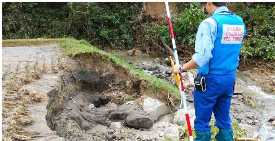
被災状況調査 (福島県二本松市戸沢地区)
