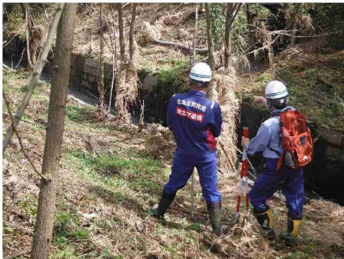
被災状況調査(河川被害箇所) (福島県須賀川市・古戸川)
