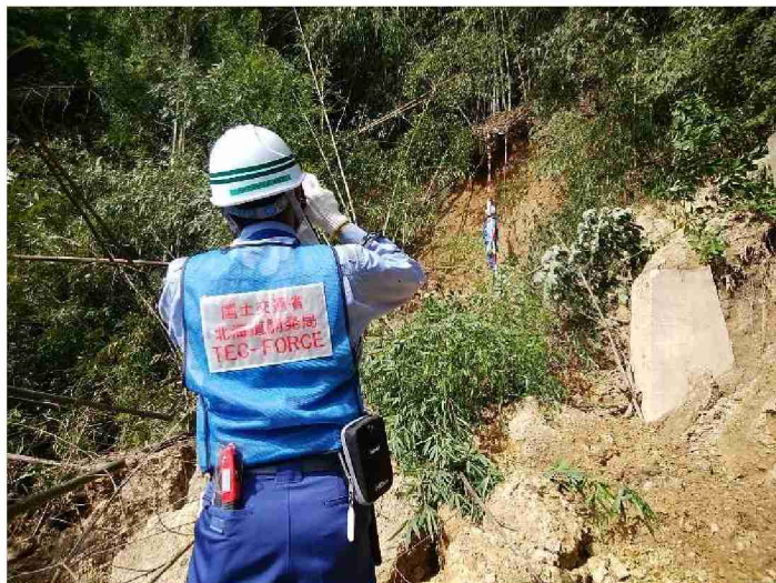
被災状況調査(崩落箇所) (福島県桑折町大字松原)
