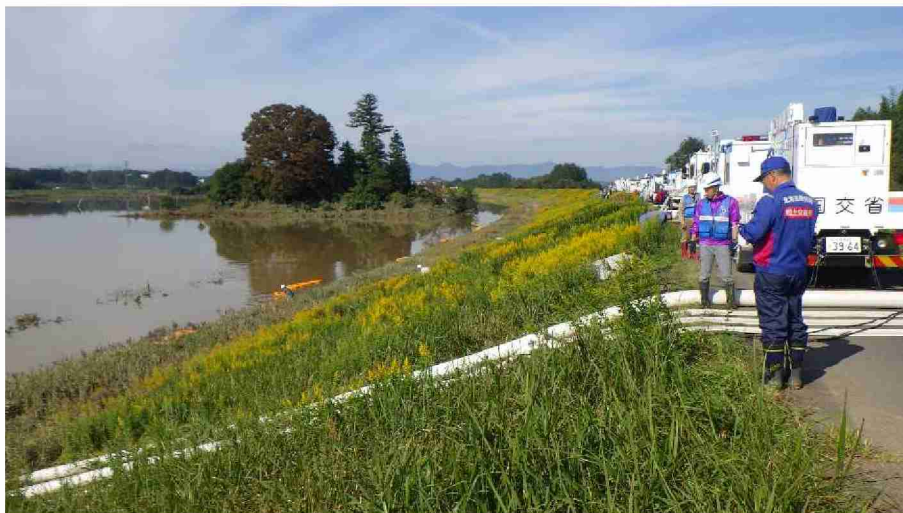
排水ポンプ車による排水作業 (浜尾遊水地)
