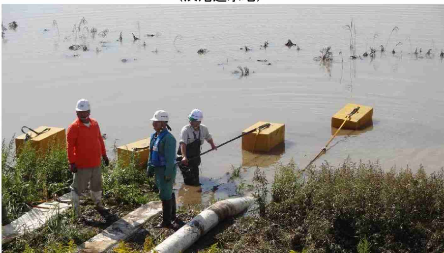
排水ポンプ車による排水作業完了、撤去 (浜尾遊水地)
