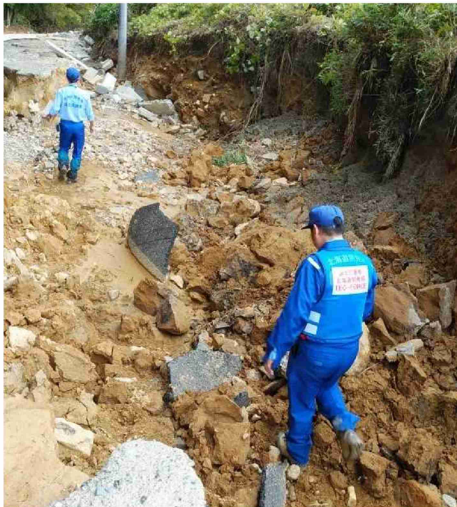
被災状況調査 (福島県二本松市戸沢地区)
