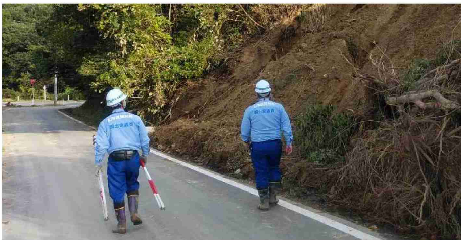
被災状況調査(福島県伊達市)
