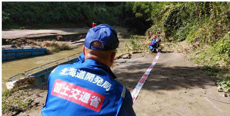
被災状況調査 (福島県二本松市戸沢地区)
