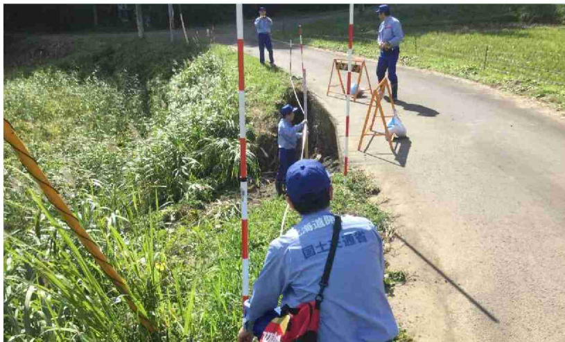
被災状況調査 (宮城県村田町)
