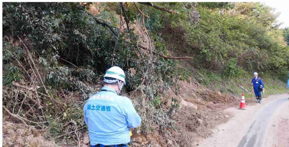
被災状況調査(福島県伊達市)
