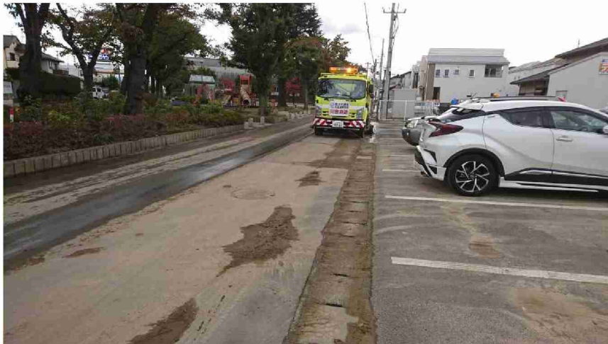
路面清掃車等による路面清掃作業 (福島県郡山市)
