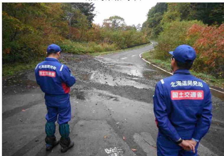
被災状況調査 (福島県相馬市)
