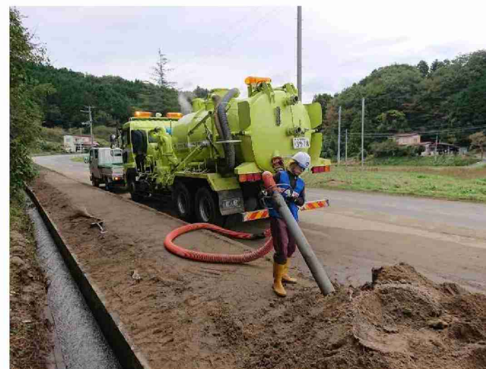
側溝清掃車による側溝清掃作業 (宮城県角田市)
