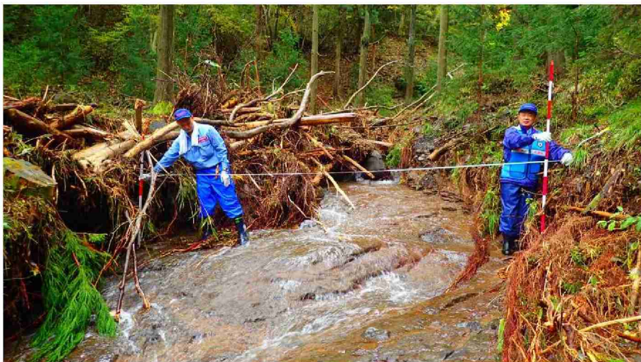
被災状況調査 (宮城県丸森町)
