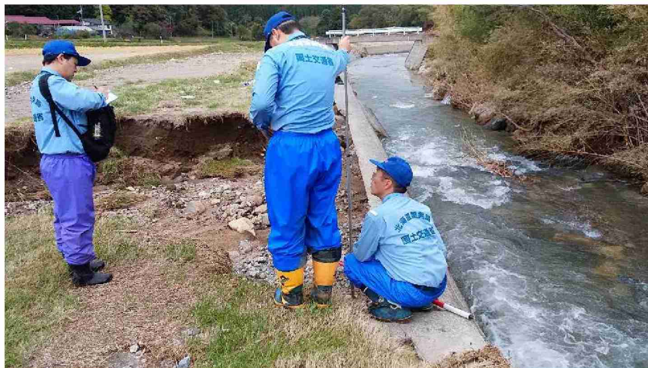
被災状況調査 (宮城県丸森町)
