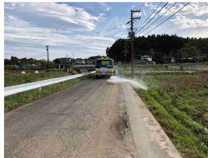
路面清掃車等による路面清掃作業 (宮城県村田町)
