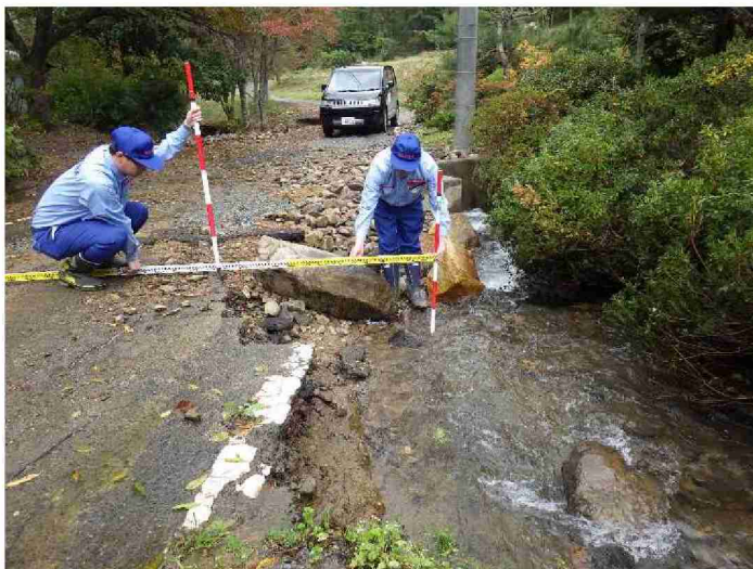
被災状況調査 (宮城県丸森町)
