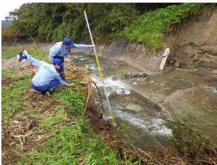
被災状況調査 (宮城県丸森町)
