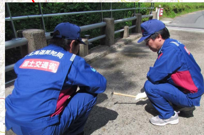
菊池市内の橋梁を調査する道路班
