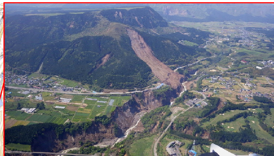
阿蘇大橋地区の土砂崩壊現場（5月1日撮影）
