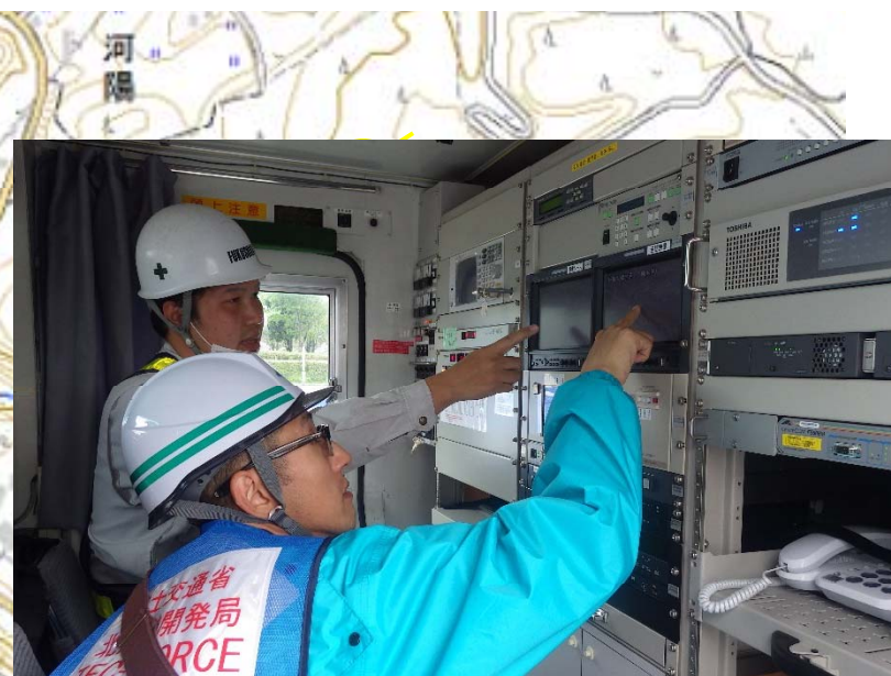
崩落法面観測装置で監視を行う砂防班(5月7日)
