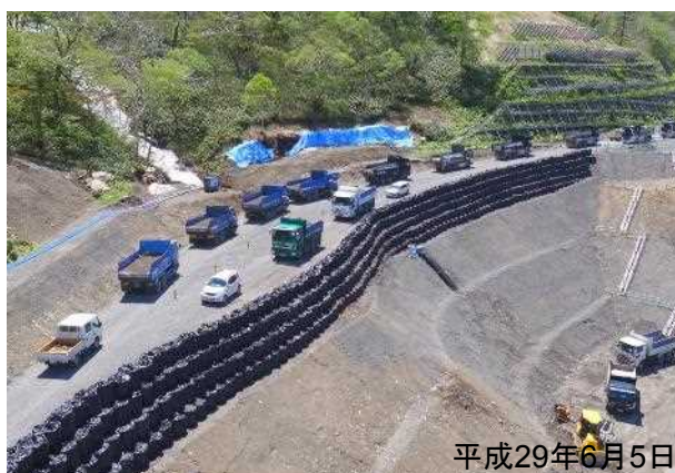
雪解けによる浸水防止のためのシート敷設
