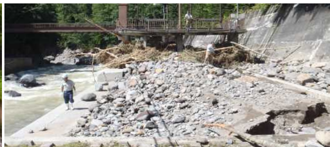
被災後（上流より）頭首工土砂吐の閉塞
