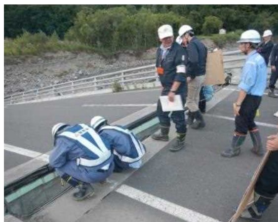
国総研調査 町道9線橋(美瑛町) 8月31日～
