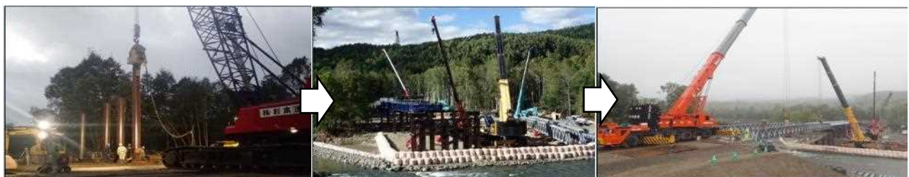
仮橋施工状況
