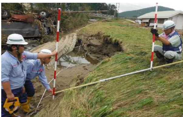
排水路被害の調査
