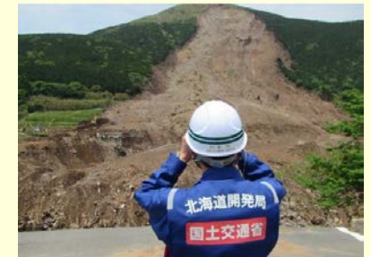
国道57号阿蘇大橋地区 斜面監視
