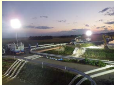
H27関東・東北豪雨(宮城県) 排水作業
