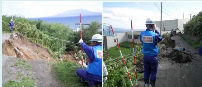
礼文小学校箇所被災状況調査
