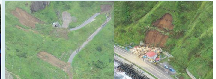
道道元地香深線被災状況
