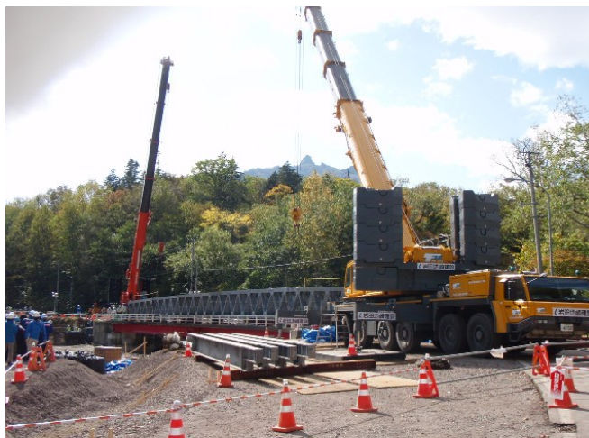
写真 一般国道４５３号 奥漁川橋への応急組立橋の架設
