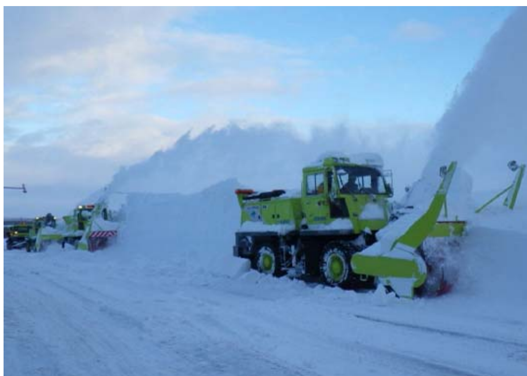
吹きだまりの除雪作業(R243 弟子屈町虹別付近)
