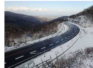
復旧工事完了
