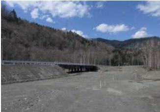
仮橋架設完了
