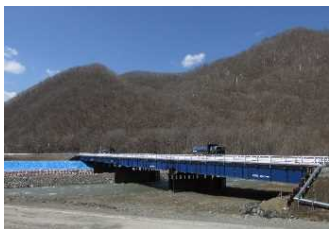
仮橋架設完了
