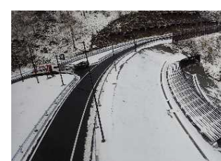
復旧工事完了
