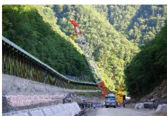
基礎復旧工事完了
