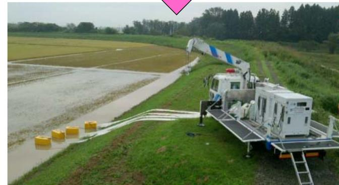
夜通しの排水作業により水深が2mほどもある湖面のようだった湛水域を解消(9月12～13日、栗原市)
