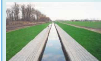
基線排水路（整備後）
