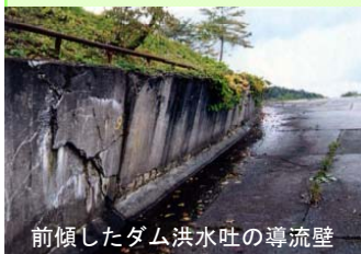
老朽化した側壁の崩壊
