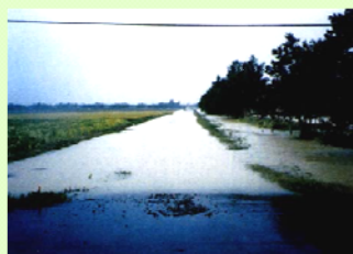
法面崩壊、土砂の堆積による河床高、断面狭小
