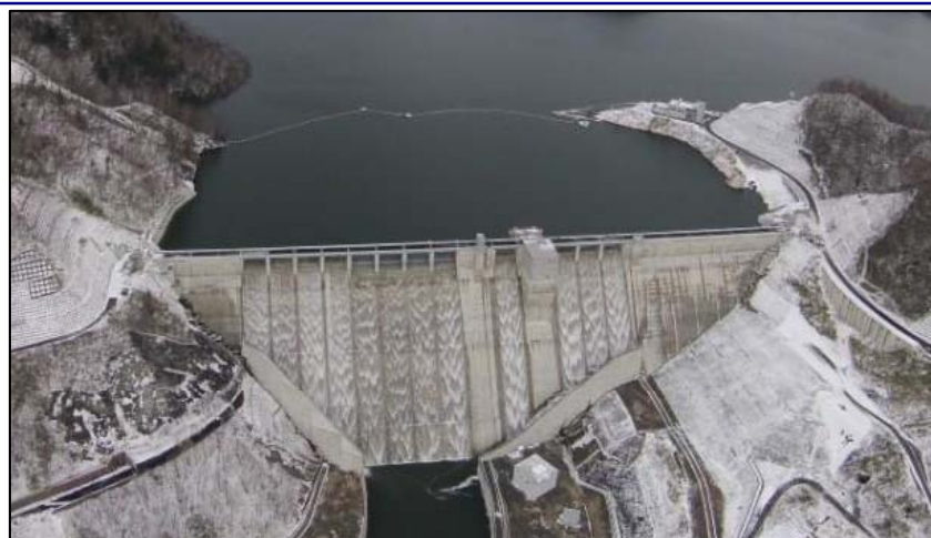
試験湛水(洪水時最高水位到達の越流状況) 平成26年11月14日
