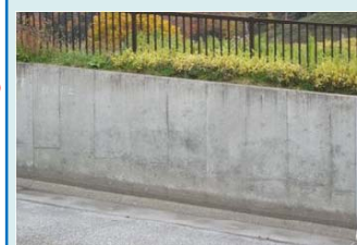
ダム洪水吐（整備後）
