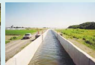
当別幹線水路（整備後）
